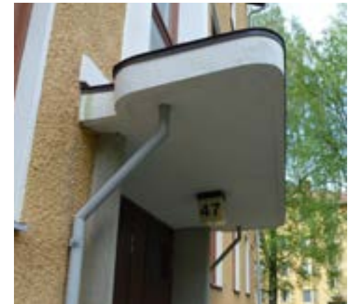
Kuva: Porrashuoneen sisäänkäynnin betonirakenne katos, as.oy Koskentie.
