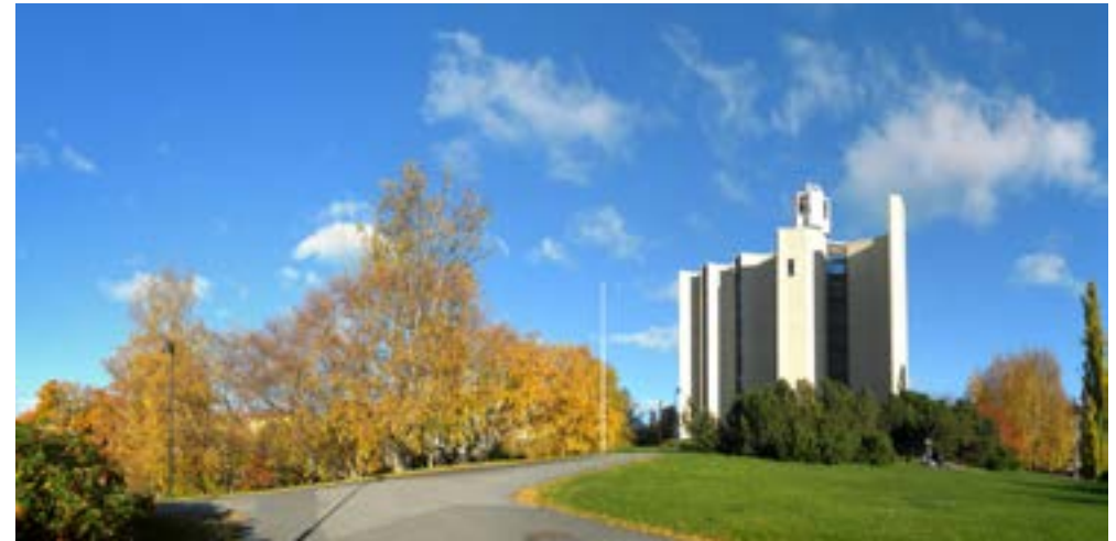
Kuva: Näkymä Sammon aukiolta Kalevan kirkolle
