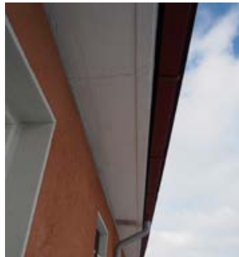
Kuva: Betoniräystä, as.oy Teiskontie 25
