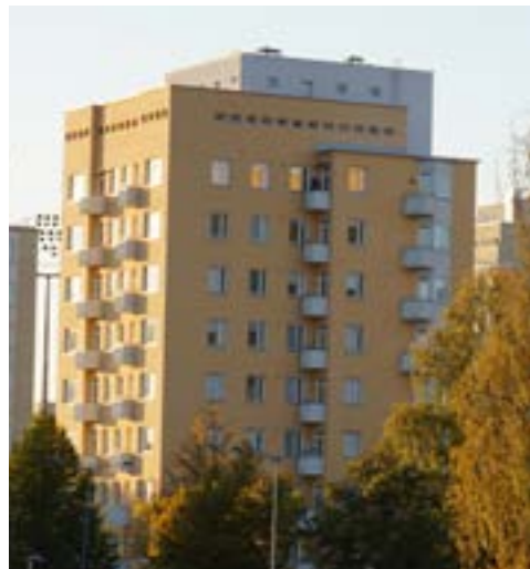
Kuva: Tasakatto, as.oy Teiskontornit
