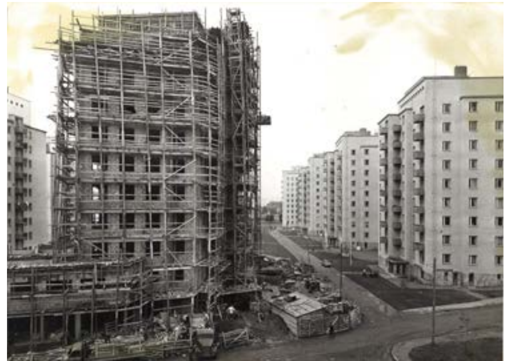
Kuva: Kalevan tornin, viimeinen, nk. miljoonatorni rakenteilla vuonna 1955. Kuva E. M. Staf, Tampere-seuran kuva-arkisto.
