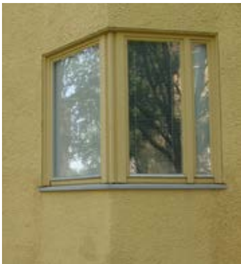
Kuva: Kunnostettu erkkeri-ikkuna, as.oy Koskentie
