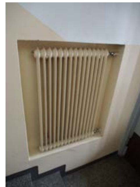
Kuva: Vesikiertoinen lämmityspatteri porrashuoneessa.
